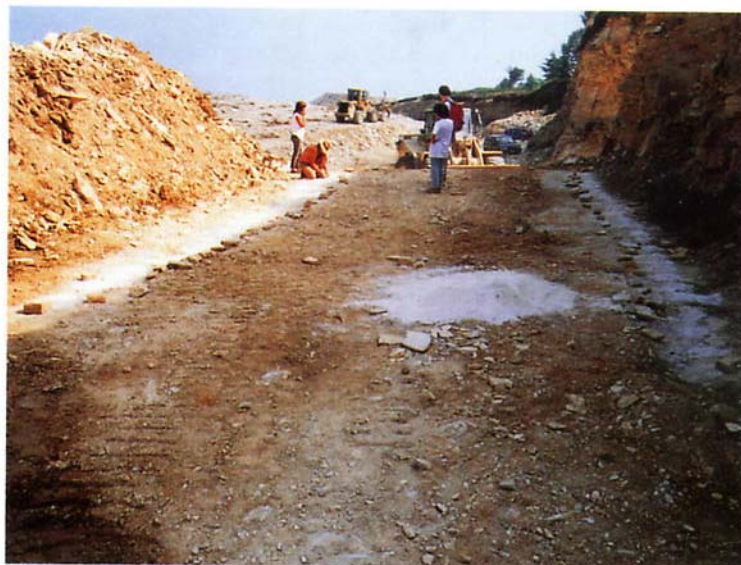
Caricamento di una volata sperimentale in trincea progettata dagli specialisti del DIGET del Politecnico di Torino
