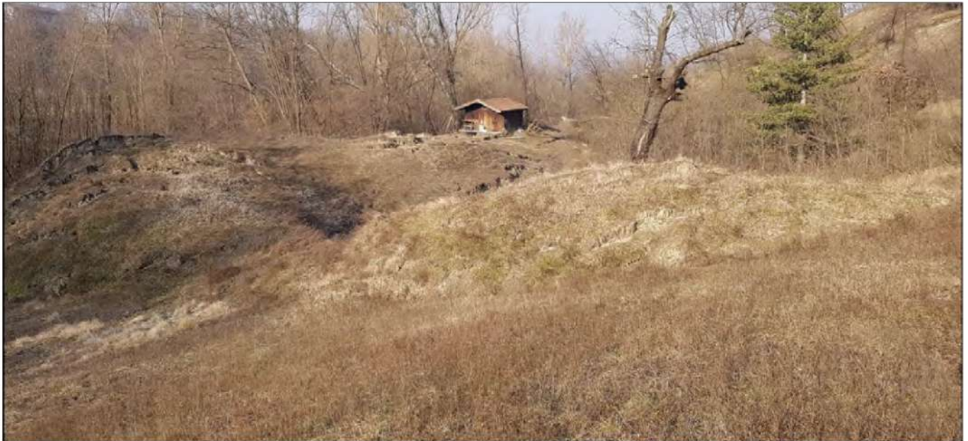
FIGURA 7. Particolare del margine occidentale della frana, nella parte basale ove sorge un capanno, con sollevamento verticale di almeno 7 metri del fronte frana, e avanzamento del fronte frana di circa 60 metri ad invadere il T. Ardana.
