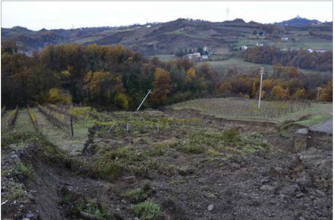
FIGURA 5. Cascina Sciotra porzione NordOvest della Nicchia di distacco.
